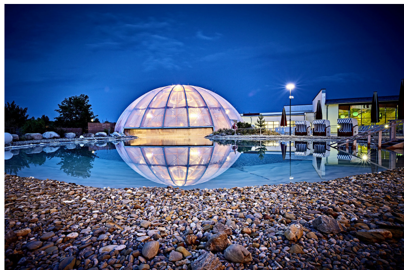
Franken-Therme, Bad Windsheim, Freilandmuseum Bad Windsheim
